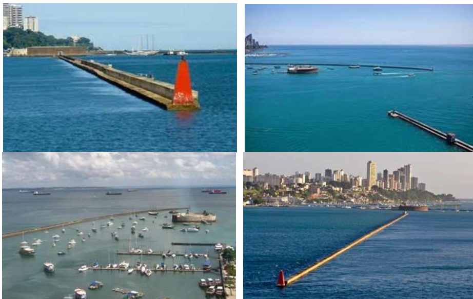
Figura 5: Obras de Abrigo do Porto de Salvador Fonte: CODEBA
